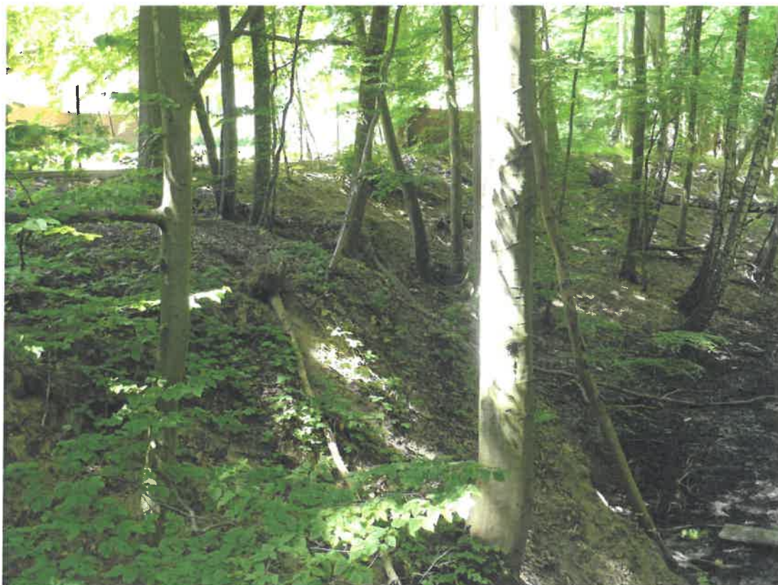
Fot. 3. Górna krawędź osuwiska dochodząca do ogrodzenia.
