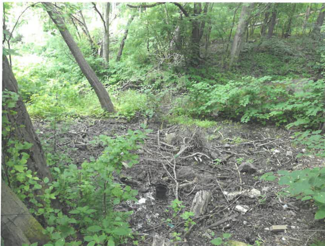
Fot. 1. Wypływy i wysięki z skarpy osuwiska.
