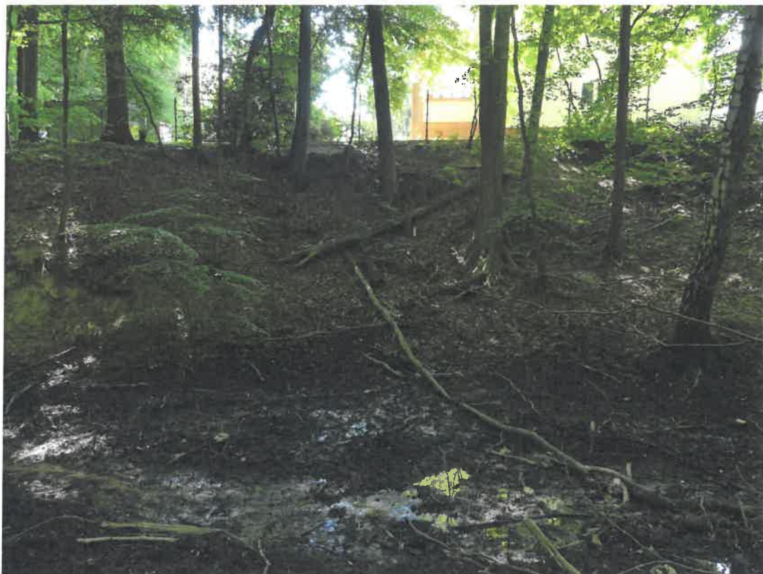
Fot. 4. Widok południowej części osuwiska.
